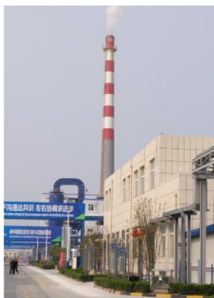
图注：超低排放设施
