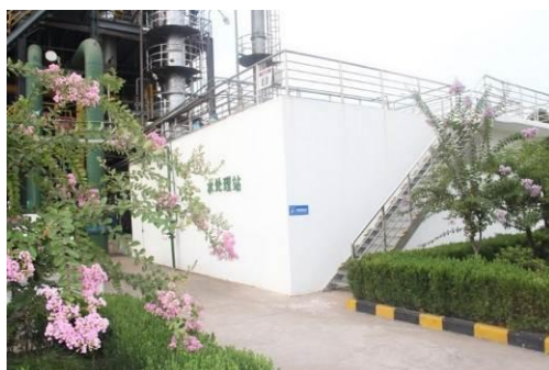
图注：污水处理站
