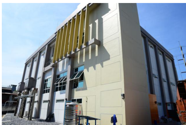
菲律宾 230kV MAGDUGO 变电站成功送电
