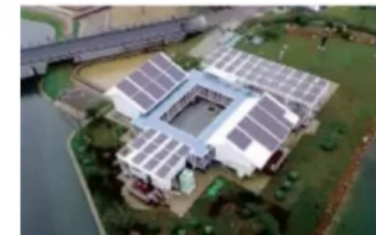
东南大学“梦想居”未来屋示范 项目 - 新一代装配式被动房
